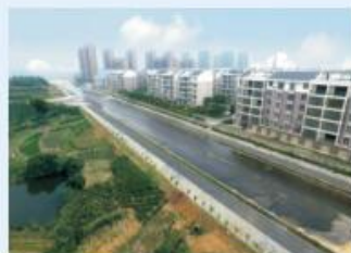
杨柳路及香樟路道路及排水工程（二标段：香樟路） 施工单位：荆门市安捷市政工程有限公司 监理单位：荆门市建筑设计研究院
