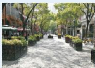
汉阳历史文化风貌街区整治与保护工程（中央街周边新建 设施改造及早期建筑修缮工程）道路工程（含步行道）及排水工程 施工单位：武汉建工集团股份有限公司 监理单位：武汉华立建设项目管理有限公司
