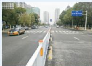
大冶市观山路刷黑改造工程 施工单位：黄石市市政工程有限责任公司 监理单位：湖北华泰工程建设咨询有限公司
