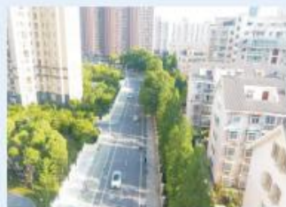
锦绣路（潜江大道-滨江大道）道路排水工程 施工单位：武汉联达市政建设工程有限公司 监理单位：武汉天龙监理有限责任公司
