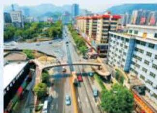
十堰市茅箭路道路改造工程 施工单位：十堰市市政建设工程有限公司 监理单位：湖北华鹏建设管理有限公司
