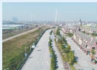
潜水县滨江新区沿江大道二标段【潜江潜江潜江沿江大道 （潜江四路）市政道路工程】 施工单位：湖北振天建筑工程有限公司 监理单位：武汉天龙监理有限责任公司
