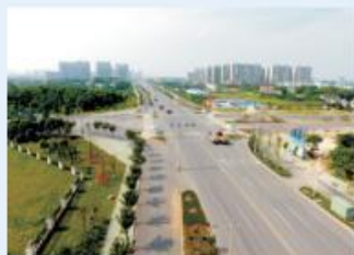
高山大道改扩建工程一标段（鄂东大道-城际铁路） 施工单位：鄂州市市政工程公司 监理单位：鄂州市工程建设监理公司
