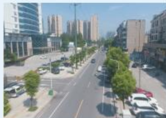
金龙路（武德路—北京路）道路改造工程 施工单位：荆州市路远市政工程有限责任公司 监理单位：珠海巨业建设监理有限公司
