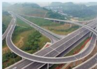
宜昌市江城大道(南嘴长江大桥—夷桥路)市政工程及 江南二路1#桥桥梁工程 施工单位：中文第一公路工程局有限公司 监理单位：葛洲坝集团项目管理有限公司
