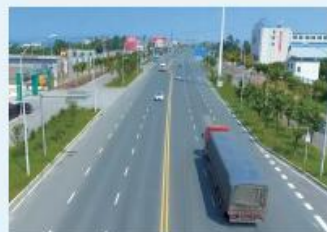
荆门南高速出入口综合整治工程 施工单位：广州建筑股份有限公司 监理单位：武汉市政工程设计研究院有限责任公司 王永超 摄
