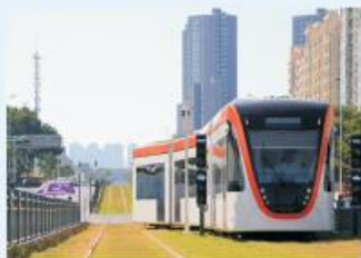
大汉阳地区现代有轨电车试验线工程 施工单位：武汉市市政建设集团有限公司 中国铁建电气化局集团有限公司 监理单位：上海天佑工程咨询有限公司
