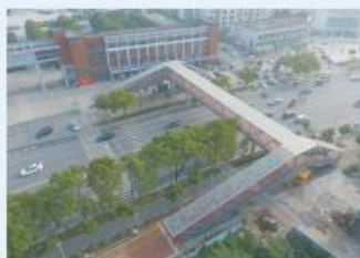
荆门北高速出入口综合整治工程 施工单位：武汉市市政建设集团有限公司 监理单位：武汉华社工程建设科技有限公司
