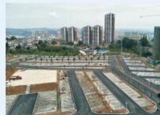
宜昌三峡旅游咨询服务中心(夜明珠停车场)项目土石方、 生态停车场及市政配套设施工程 施工单位：湖北沛雨建设有限公司 监理单位：中冶南方武汉威仕工程咨询管理有限公司
