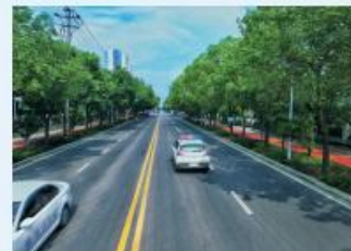
枝江市七星大道刷黑改造工程 施工单位：湖北国中建设有限公司 监理单位：杭州天恒投资建设管理有限公司
