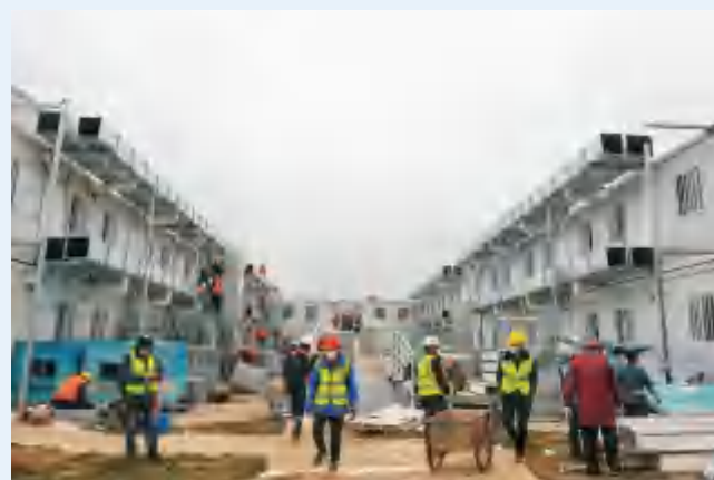
医院在紧张施工中
