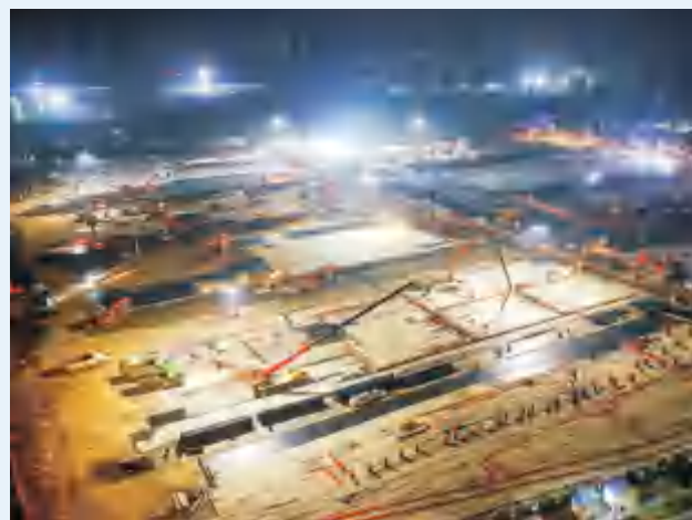
夜以继日的施工
