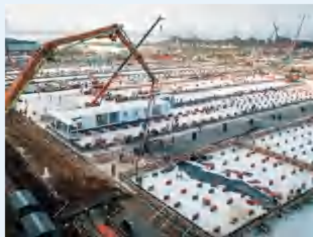
医院在紧张完工中
