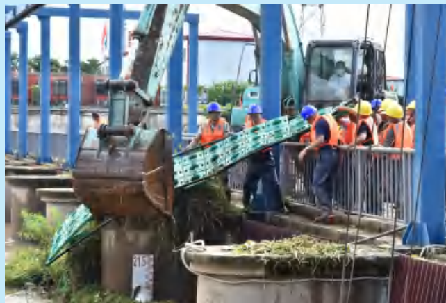
防汛抢险突击队在汤逊湖泵站清杂 陈昌红 摄
