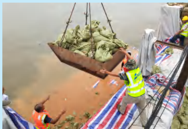
防汛队员用砂袋加固八铺街堤坝 马 良 摄
