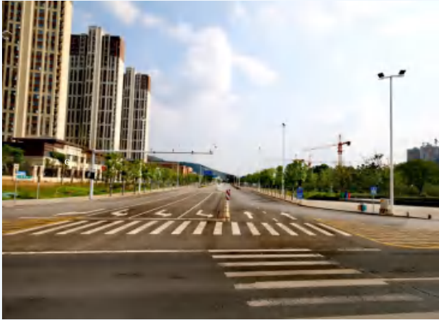
檀溪湖保障房配套道路新建工程第一子项：双湖路新建工程 施工单位：襄阳市政建设集团有限公司 监理单位：武汉建设技术发展有限公司 王增辉 袁廷炬 摄
