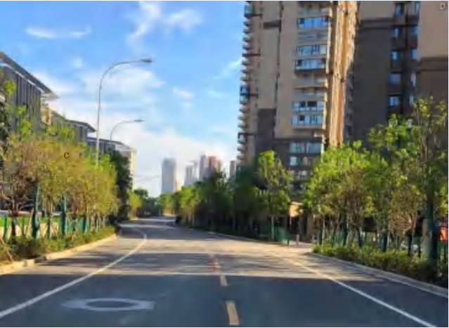
阳新路（汽渡路~腰路堤路）道路排水工程 施工单位：武汉天创市政建设工程有限公司 监理单位：武汉天龙监理有限责任公司 曾颖静 摄
