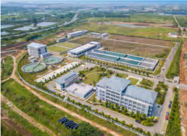
军山自来水厂新建工程（一标段） 施工单位：武汉建工集团股份有限公司 监理单位：武汉方正工程建设项目管理有限公司 肖 晞 摄
