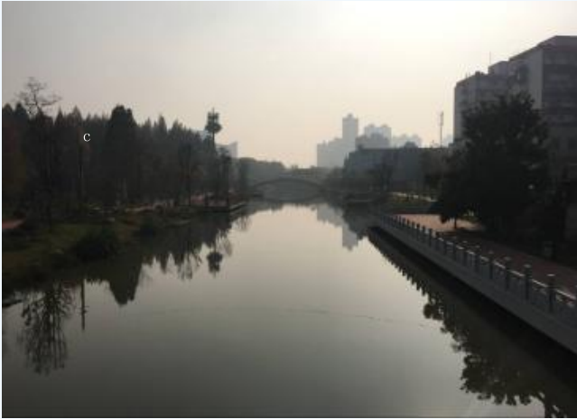
青山港及二号明渠综合整治工程（青山港子项）一标段 施工单位：武汉市汉阳市政建设集团有限公司 监理单位：北京东方华太建设监理有限公司 刘 庆 摄
