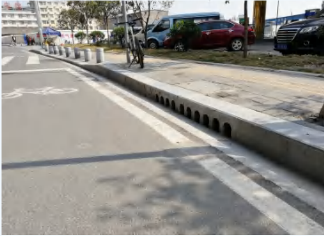
宜昌市夜明珠路（宜秭路-东山大道）综合改造工程 施工单位：中国葛洲坝集团第一工程有限公司 监理单位：湖北高路公路工程监理咨询有限公司 揭晓玲 摄
