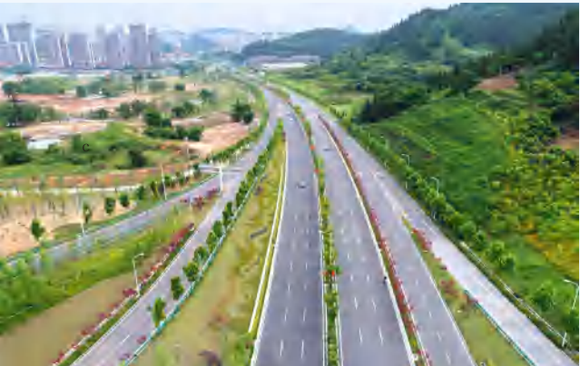
宜昌市夷桥路快速化改造工程 施工单位：湖北益通建设股份有限公司 监理单位：济南市建设监理有限公司 李会琴 摄
