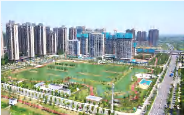
荆北片区湿地水系公园建设项目 施工单位：湖北路远建设集团有限公司 监理单位：湖北德馨建设工程咨询有限公司 刘尧 摄
