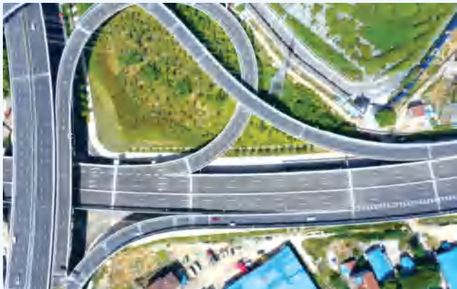
江汉六桥汉阳岸接线（汉阳大道至龙阳湖北路）工程
