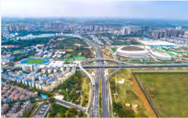
东西湖区金山大道（九通路-机场路）改扩建工程
