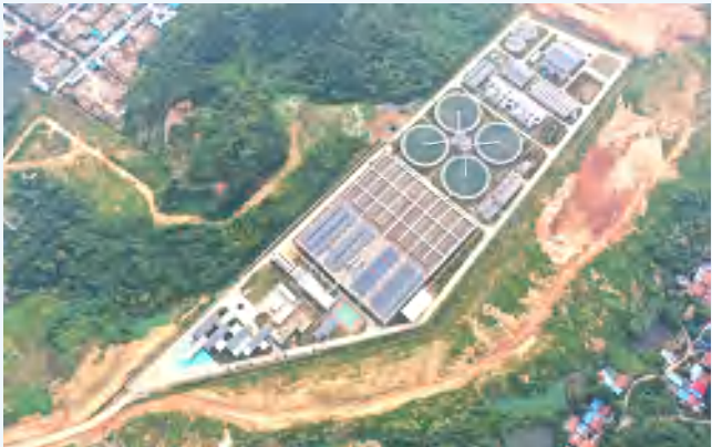
江夏区清水入江一期工程—江夏污水处理厂（一期） 施工单位：中交第二航务工程局有限公司 监理单位：武汉方正工程建设项目管理有限公司 刘博傲 摄
