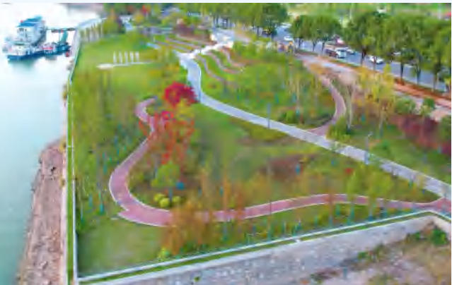
湖北省宜昌市长江岸线整治修复项目（柏临河入江口—猗亭古战场）三标段 施工单位：湖北沛函建工集团有限公司 监理单位：宜昌宏业工程项目管理有限公司 马迪 摄
