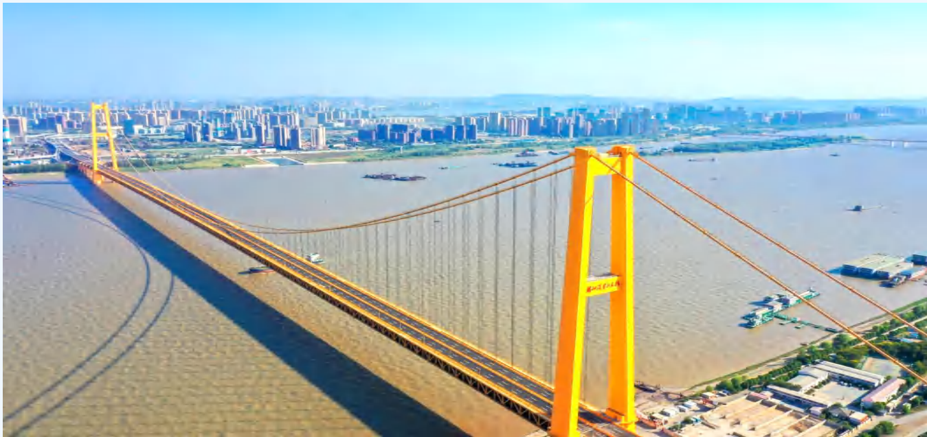
武汉杨泗港长江大桥（鹦鹉堤—八铺街堤）正桥工程（2021年鲁班奖工程）
