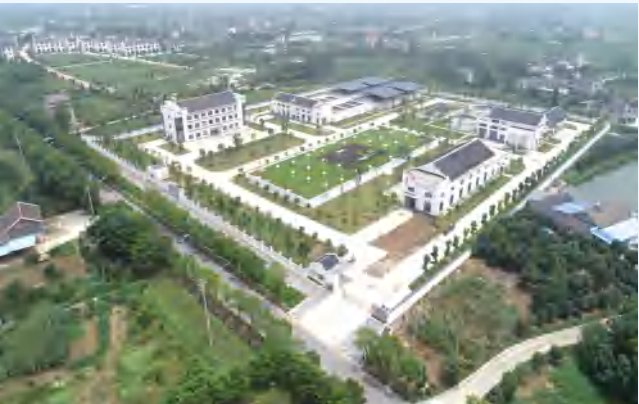
枝江市仙女水厂新建工程 施工单位：天恩建设集团有限公司 监理单位：杭州天恒投资建设管理有限公司 杨雄 摄
