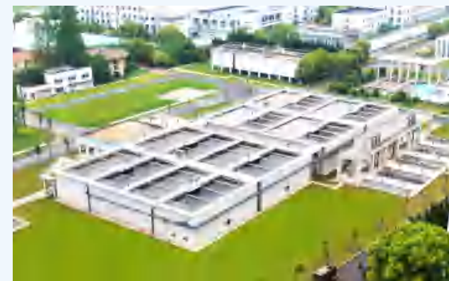
工程名称：白沙洲水厂改扩建工程 施工单位：武汉市水务建设工程有限公司 监理单位：武汉扬子江工程监理有限责任公司
