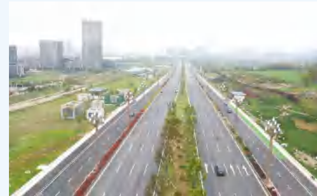
工程名称：高新大道（外环线-短咀里湖大桥）综合改造工程总承包（EPC） 施工单位：武汉市市政建设集团有限公司 监理单位：武汉市东盛元建设项目管理有限公司
