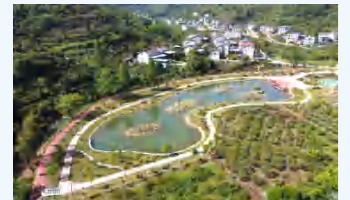
项目名称：联棚河流域生态保护修复工程 施工单位：湖北国通领驭建设集团有限公司 监理单位：三峡大学（湖北）设计咨询研究院有限责任公司
