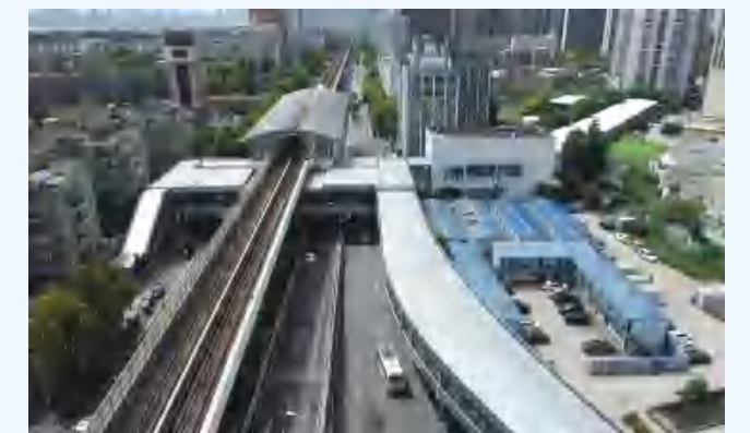
工程名称：武汉新荣轨道交通换乘工程施工总承包 施工单位：武汉市市政路桥有限公司 监理单位：中铁二院（成都）咨询监理有限责任公司
