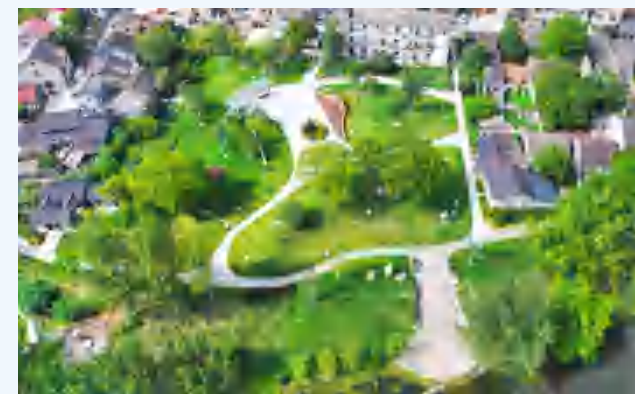
工程名称：当阳市河溶镇“擦亮小城镇”建设工程（EPC） 施工单位：湖北华信建设工程有限公司 监理单位：武汉平安建设工程项目管理有限公司
